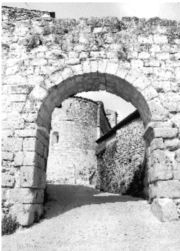
El portal de Vilademuls permet veure la importància de la sagrera en la delimitació de l'espai urbà.
